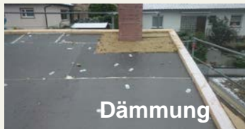
© Gottlieb Bedachung GmbH Hohenstein
